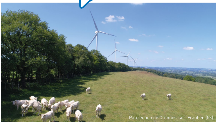
Parc éolien de Crennes-sur-Fraubée (53)
